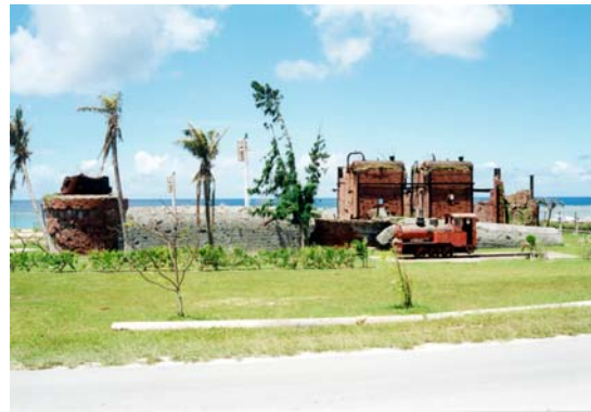
写真 20 旧南洋興発ロタ製糖所汽罐室と煙道 (2003 年 3 月)
