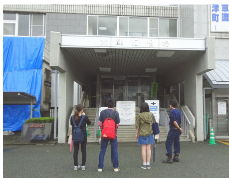
地震によって使用できなくなった 大津町役場庁舎
