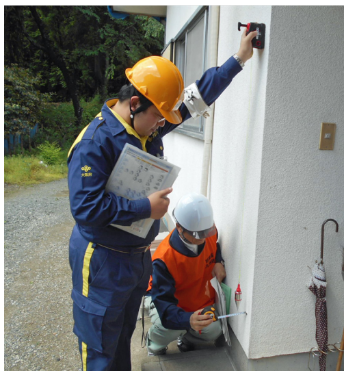
建物の被害認定調査
