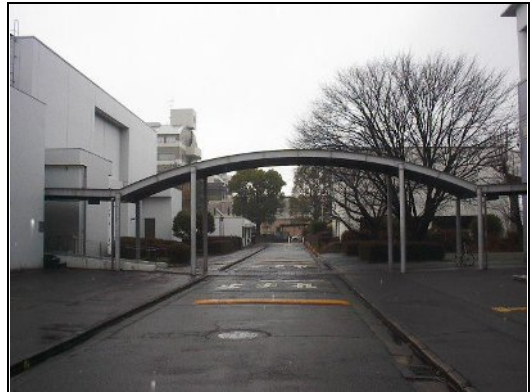
敷地内高さ制限箇所
