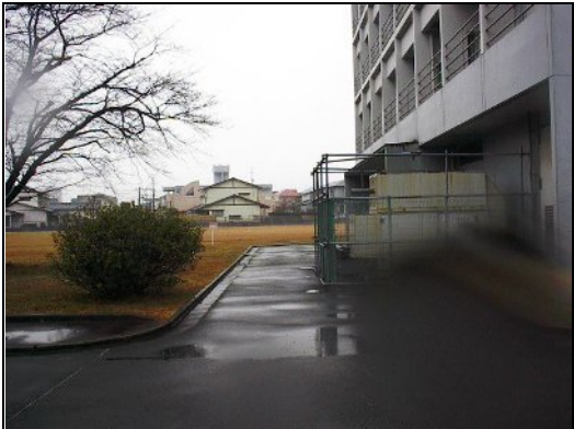
南側通路・西→
