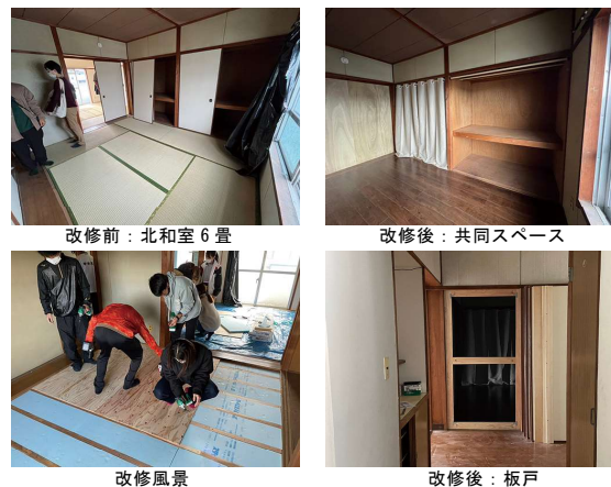
写真1：長嶺団地・改修写真
