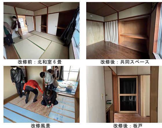
写真1：長嶺団地・改修写真
