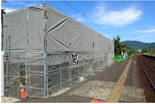
写真 2 工事中の網田駅
