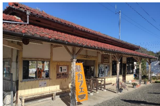
写真 1 県内最古の木造駅舎「網田駅」
